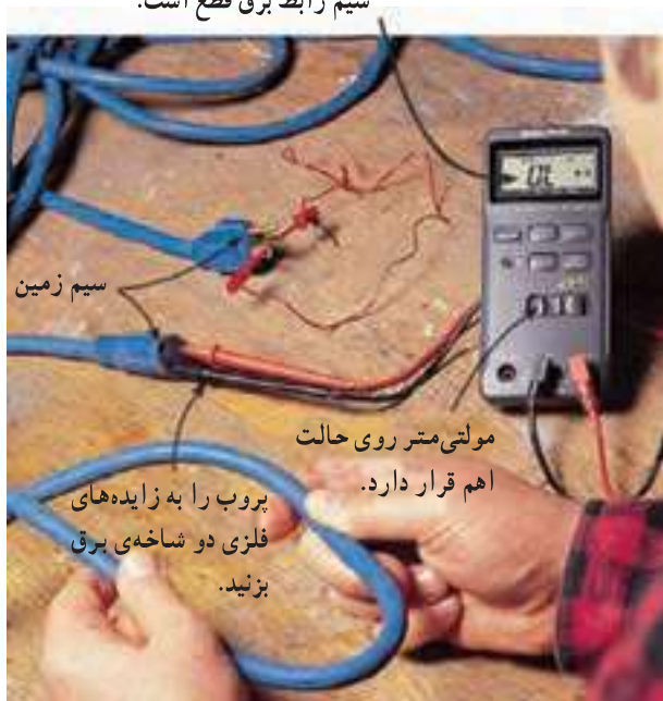
شکل ۲-۸۰ — آزمایش سیم رابط برق دستگاه.
