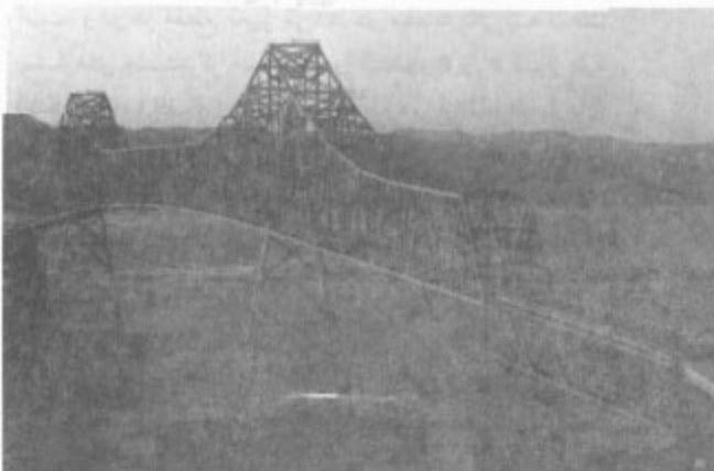
شکل ۹-۱ خربای این پل از عضوهای دوتیرویی کششی یا فشاری تشکیل شده است.
