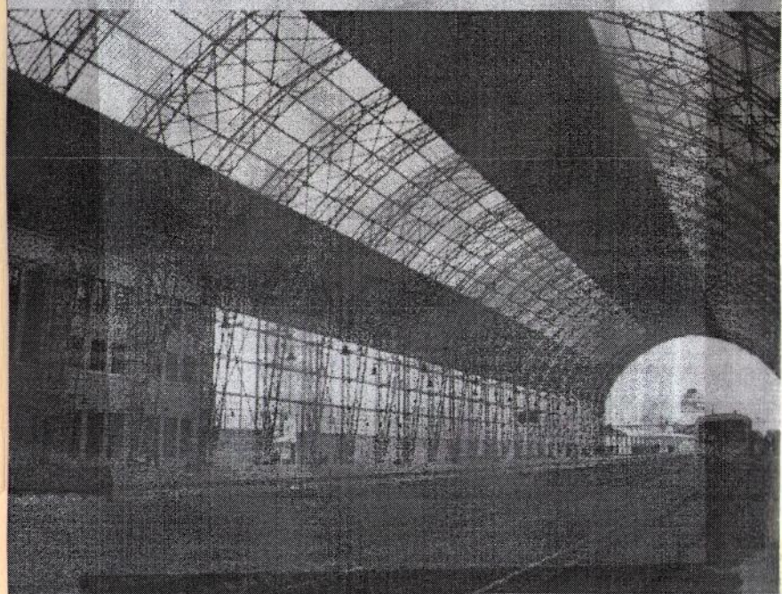
شکل ۱-۲۴ استفاده از سازه‌های فولادی در فضاهای عمومی
